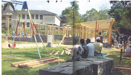
Construction d'habitations de transition au Sri Lanka, faites pour être démontées. Les matériaux seront réutilisables lors de la construction des maisons permanentes.
